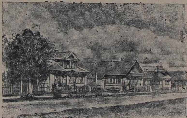
В колхозе „Объединенный труд“, Пошехоно-Володарского района, Ярославской области, идет строительство колхозных домов. На снимке: дома колхозников, построенные в дни Отечественной войны для семей военнослужащих. Фотохроника ТАСС
