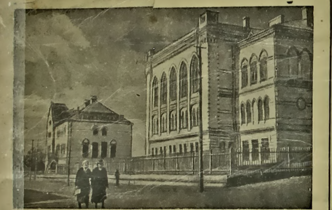
На гарадах Савецкага Саюза. Будынак калгасіага і сельгасгаспа дарчага тэхнікума ў г. Сартавала Беларускай ССР.
